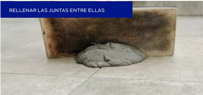
El mortero en el pegado de baldosas tiene una gran importancia en la calidad del revestimiento, ya que determina su fijación al soporte y, por tanto, la durabilidad del acabado. Los posibles problemas que pueden surgir si el mortero no se adecua a las exigencias son la falta de anclaje y, por tanto, la posibilidad de rotura.
